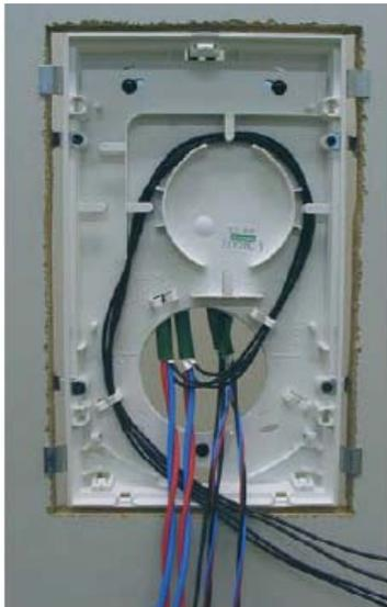
Enroulez les fibres optique d'un demi tour dans le sens inverse des aiguilles d'une montre comme montré sur la photo
