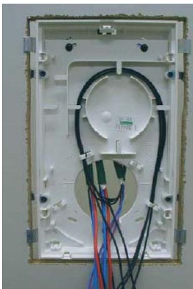
Enroulez les fibres optiques d'un demi tour dans le sens des aiguilles d'une montre comme montré sur la photo.
