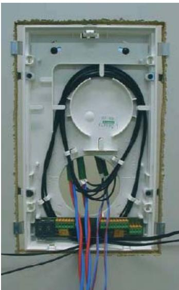
Fixez le socle de raccordement en faisant bien attention de faire passer les fibres derrière le socle comme montré sur la photo et les câbles d'alimentation devant.
